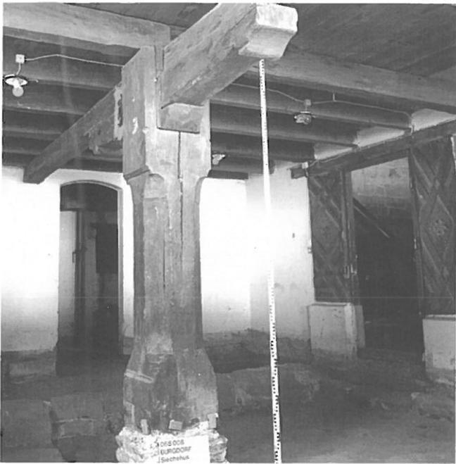
Abb. 46: Wiederverwendeter Eichenpfosten.
