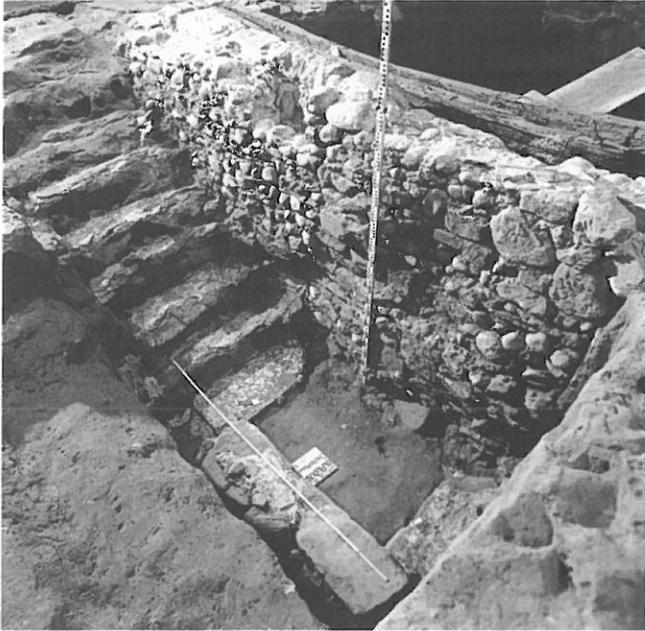
Abb. 30: Ursprünglicher Kellerzugang.
